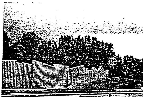
Karlsruhe (Alemania). Pantalla de hormigón con diseño singular.
